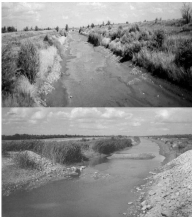
Рис. 1. Оросительные каналы с наносами и донными отложениями
